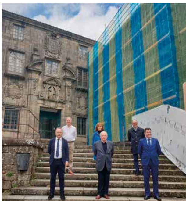
Visita del conselleiro de Cultura y el alcalde de Santiago a las obras
