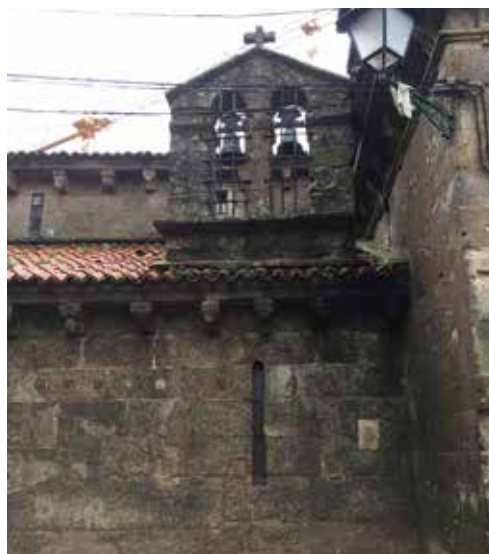
Las humedades están provocando daños tanto en las fábricas como en el interior
