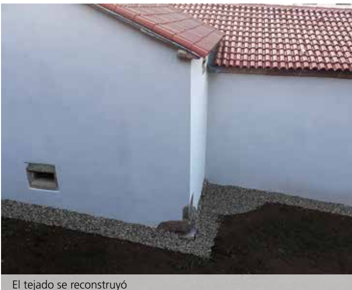
Se renovó la pintura de las fachadas y el drenaje exterior de los muros
