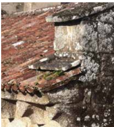
La cubierta se repondrá con teja cerámica
