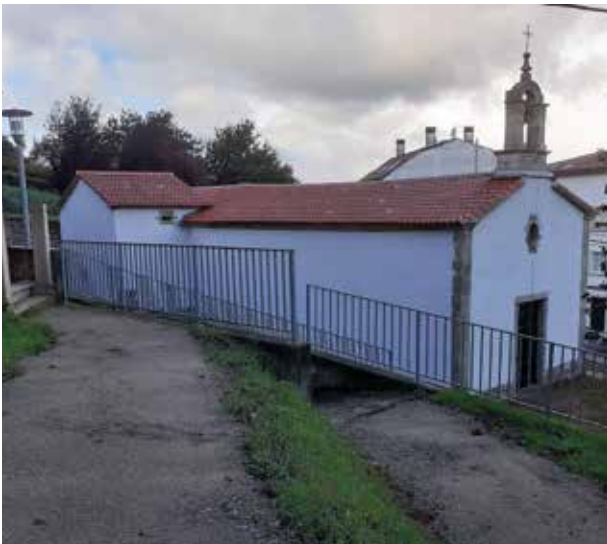
Se renovó la pintura de las fachadas y el drenaje exterior de los muros
