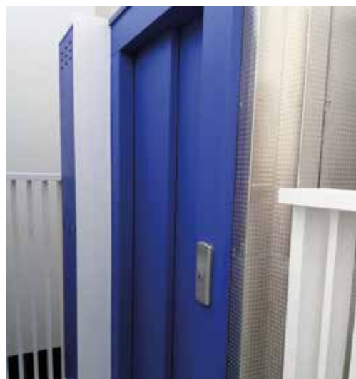
Dispone de una batería que permite realizar hasta cien viajes en el caso de cortarse el suministro eléctrico
