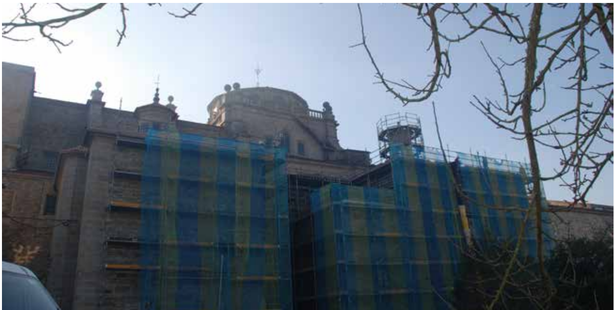
Se está realizando una limpieza y rejuntado de las fachadas
